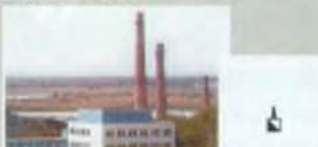
Заводы и фабрики с трубами
